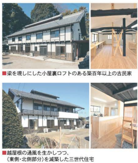
■梁を現しにした小屋裏ロフトのある築百年以上の古民家 ■越屋根の通風を生かしつつ、(東側・北側部分)を減築した三世代住宅
