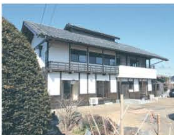
越屋根の通風を生かしつつ、(東側・北側部分)を減築した三世代住宅
