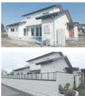
中廊下で分断された居間と食堂・台所を、梁を入れ替え柱と間仕切戸を取り除き、広くて使い勝手の良いスタイリッシュなLDKを実現
