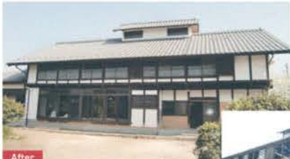
After 曳家の技術によって古民家を解体することなく移動し、長く住み続けられる家に再生
