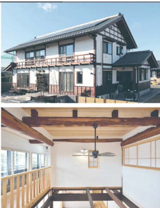
区画整理に伴う解体移築。傷んだ土台や柱などは新しい無垢材に交換。断熱改修により断熱等級5相当を実現した。太陽光発電システムを搭載
