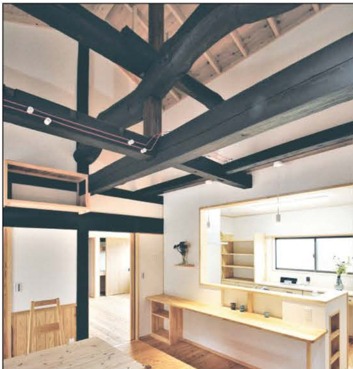
区画整理に伴う解体移築。傷んだ土台や柱などは新しい無垢材に交換。断熱改修により断熱等級5相当を実現した。太陽光発電システムを搭載
