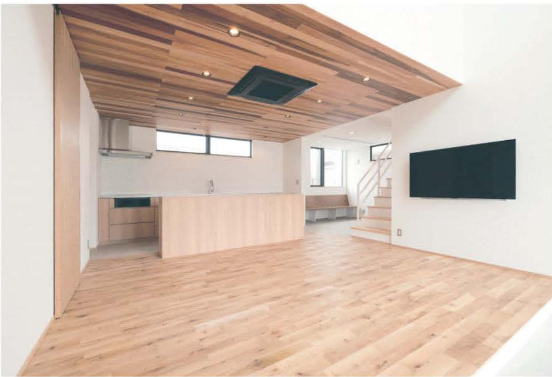
子育て世代の34坪の住まい。南面いっぱいに土間を設け、吹き抜けを介して上の階層とつながる、のびやかなワンフロアのLDK。床はオーク、天井にはレッドシダーを張った。壁付けのキッチン、窓辺のベンチといった造作が、白×木部の空間に統一感をもたらす。
