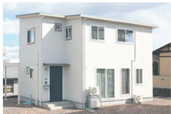
■断熱等級6・ツーバイシックス工法・ZEH仕様で快適な住宅
