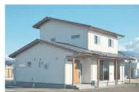
■ 外壁は塗り壁を採用
