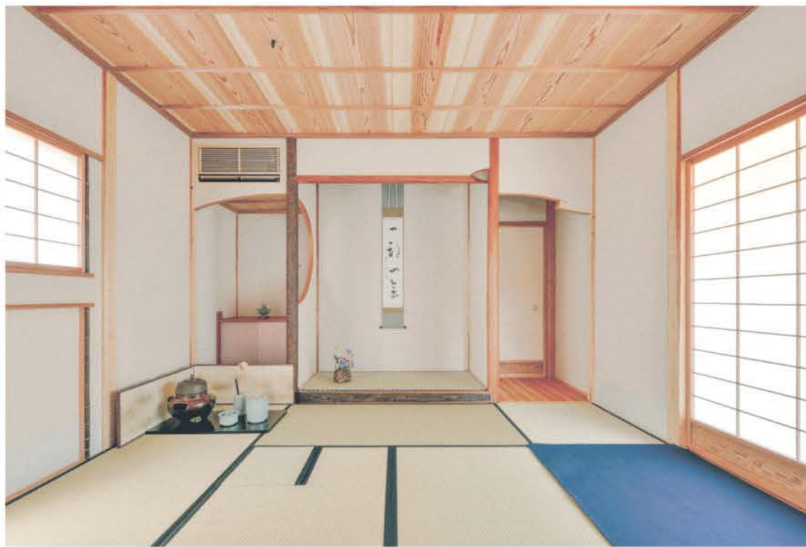
杉の竿縁天井や屋久杉の落とし掛け、床板にはケヤキ、床柱には赤松の皮付き丸太など、銘木を適材適所に配置した茶室。緩やかな弧を描く下がり壁や、塗り壁の優しい風合いが炉のある畳敷きと相まって、日本の美意識「わびさび」を感じるたたずまい。
