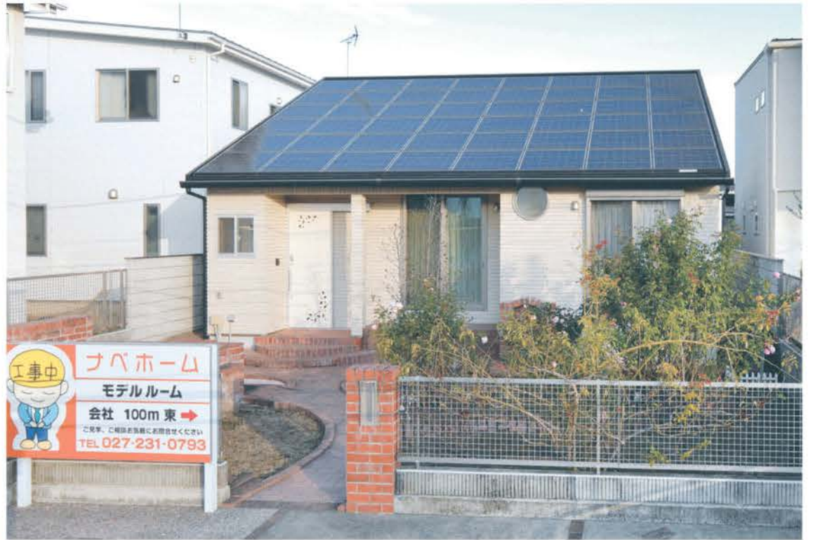
災害時には近隣住民のために煮炊きができる展示場。違いが確かめられるよう3LDKの平屋に8種類の色違いのフローリング、素材の違うサッシや窓などを取り入れた。本体価格に含まれるキッチンやバスなどの住宅設備も設置。同社で実現できる注文住宅が体感できる。
