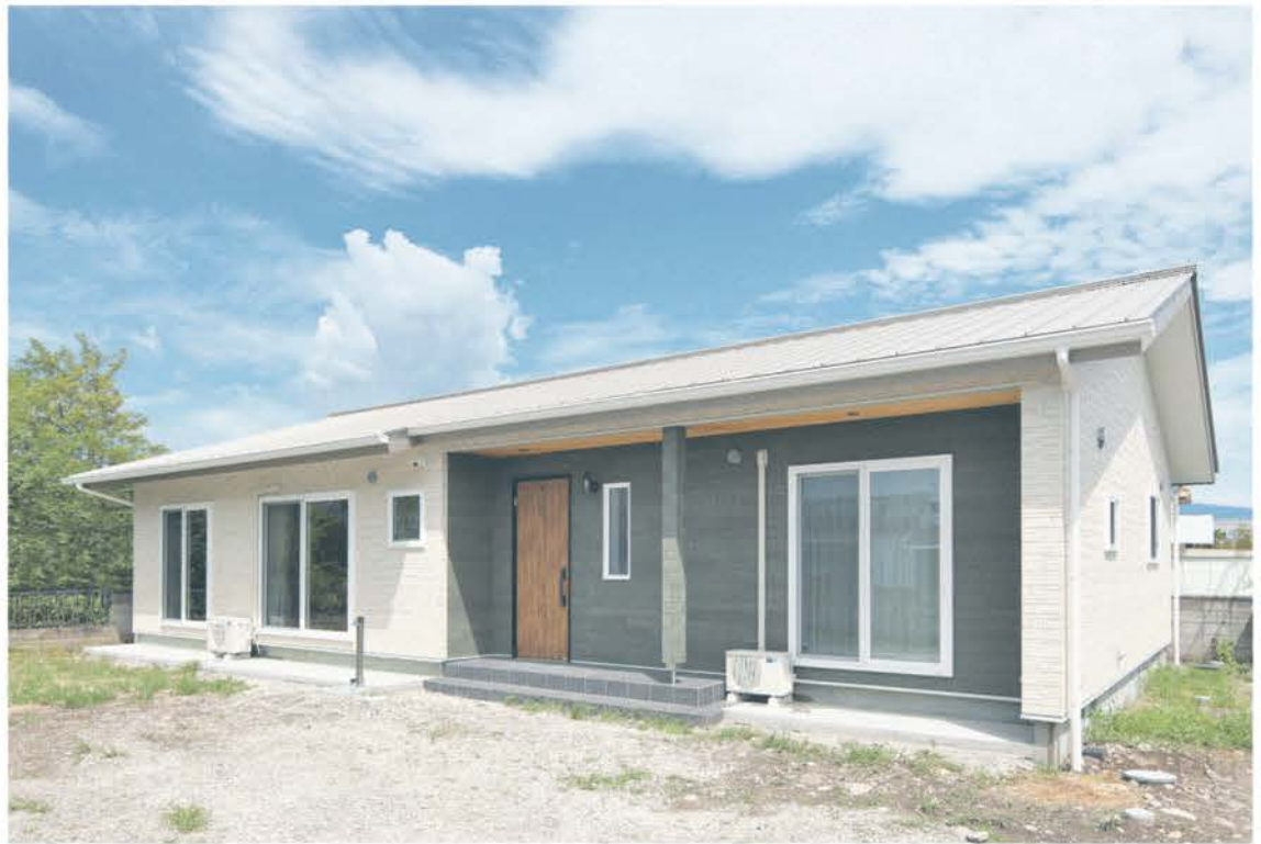
白をベースにオリーブグリーンの外壁がアクセント。切妻屋根の軒を深く出し、日差しをコントロールする平屋の二世帯住宅。玄関を境に左右で世帯を分け、室内は水まわりを介して互いの動線が回遊する。付加断熱を施した高気密高断熱の長期優良住宅。
