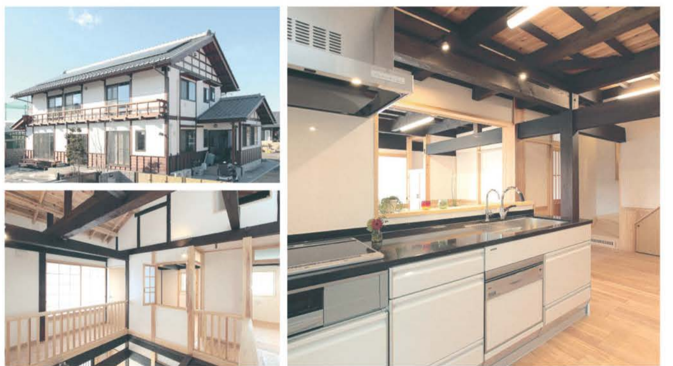
区画整理に伴う解体移築。傷んだ土台や柱などは新しい無垢材に交換。断熱改修により断熱等級5相当を実現した。太陽光発電システムを搭載
