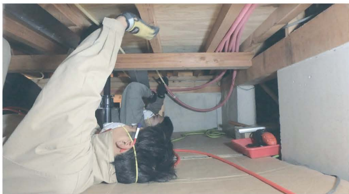
■床下後付け床暖房の施工。床下から工事をするので、施工は普段の通りの生活ができる
