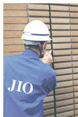
住宅外壁の劣化具合を調べる専門家 (日本住宅保証検査機構提供)
