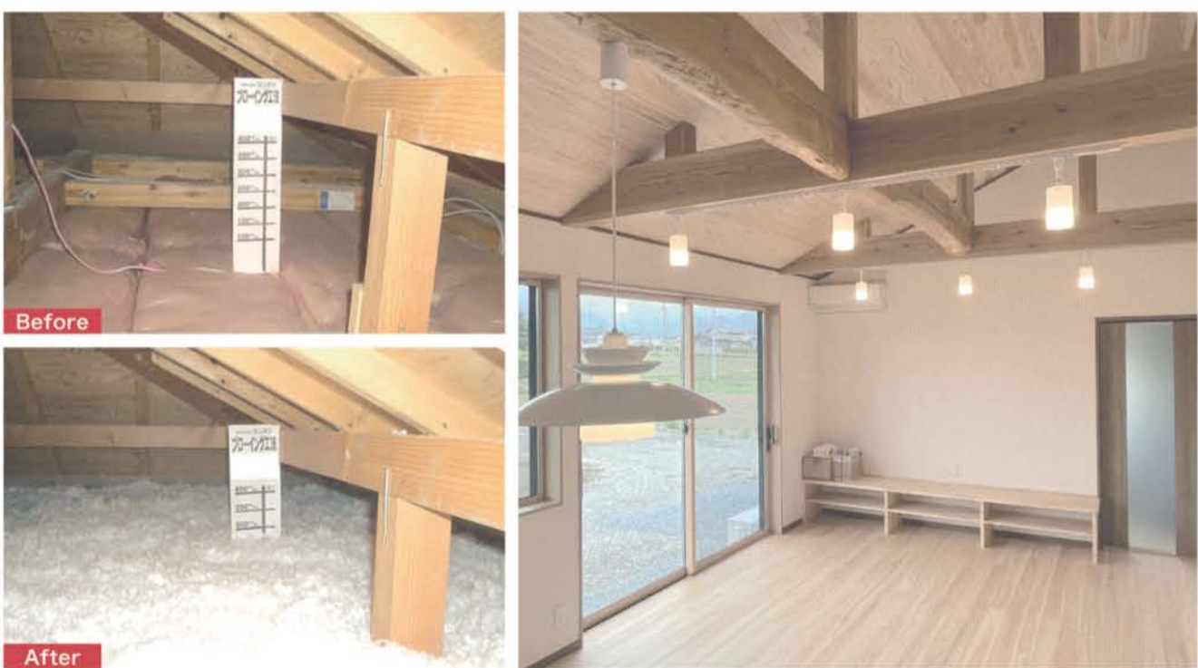
写真左は小屋裏断熱の施工例。床下と小屋裏の断熱工事と内窓の設置により、今までの家とは「別次元」の温かな家に生まれ変わる
