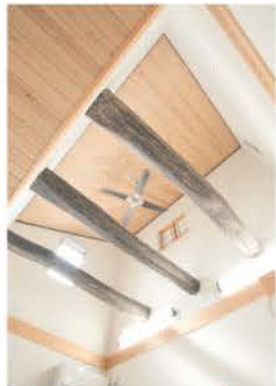
■ 古材の梁と板張り勾配天井
