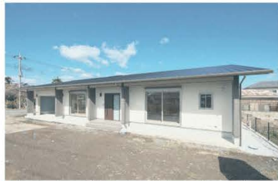
■ 太陽光パネルを搭載した、東西に伸びる約53坪の平屋建て
