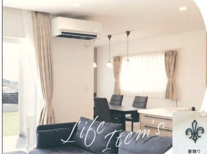
LED照明(全居室)・カーテン(全居室) エアコン(6帖用×5台)
