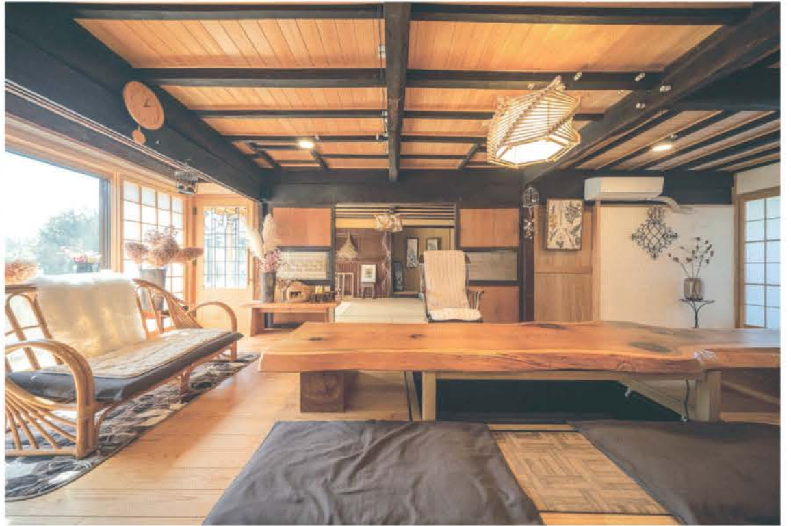
群馬県に多い養蚕農家型の家を改築したリビング。柱や梁・建具は残し、古民家の良さを生かした。古さと新しさがなじむ、ほっとできる心地よい空間になった。1階リビングと玄関、水回り(キッチン、トイレ、風呂)を改修し、外壁塗装、断熱改修工事を行った。
